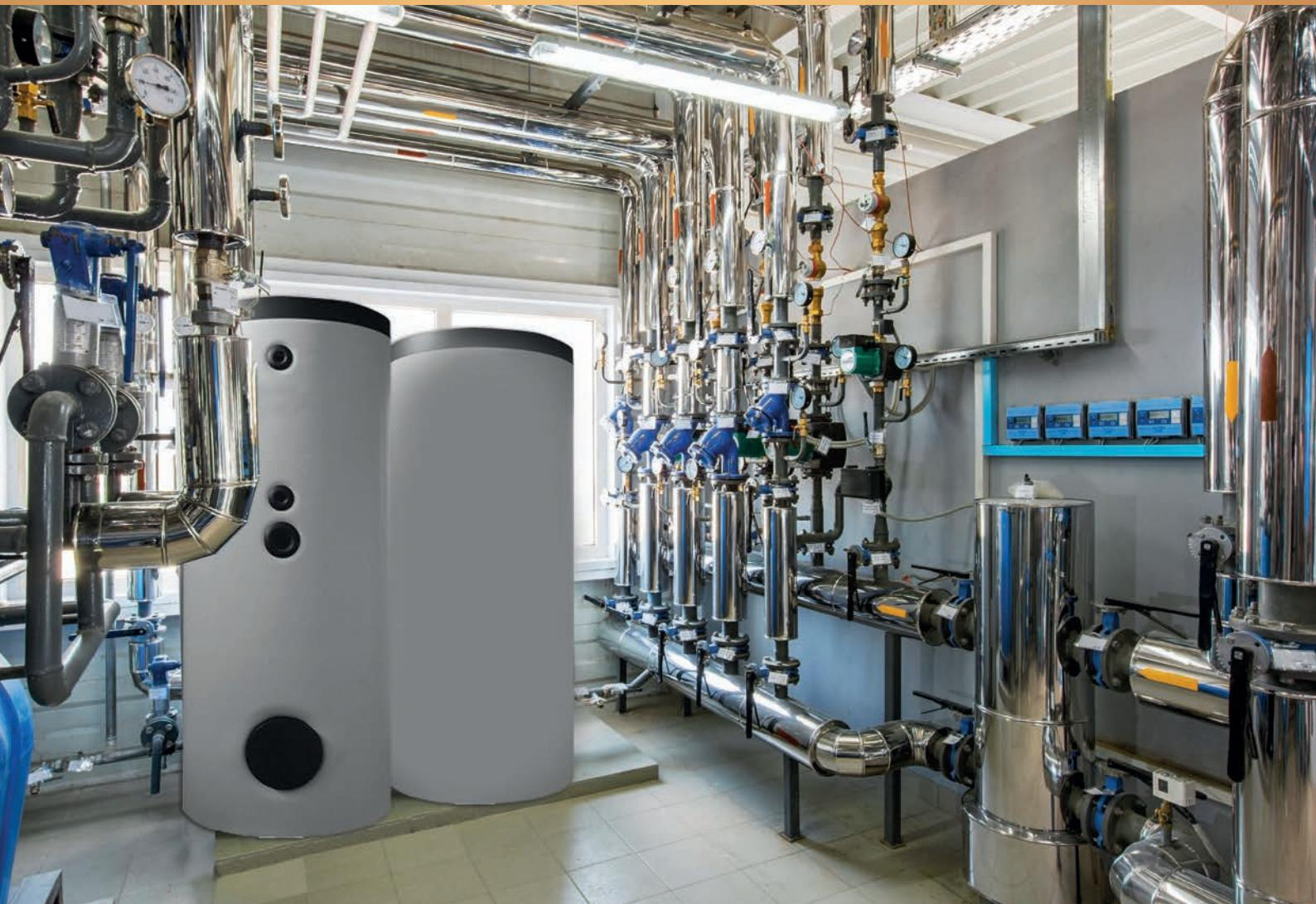
Les ballons de la série BVE-WW sont spécialement conçus pour des installations solaires avec circuit primaire. Ils sont équipés de deux échangeurs.
