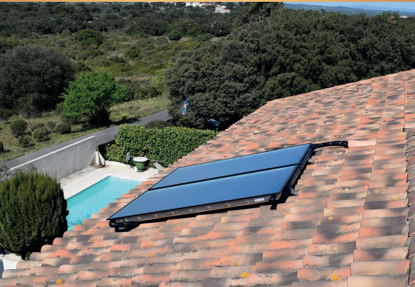
Le chauffe-eau solaire individuel est composé d'un ou plusieurs panneaux solaires, d'un ballon de stockage et d'une régulation. Le nombre de panneaux dépend de la zone géographique et du nombre de personnes habitant dans le logement. Le ballon peut être alimenté par une énergie d'appoint par le biais d'une résistance électrique, d'une pompe à chaleur ou autres chaudières (gaz, fioul, bois).
