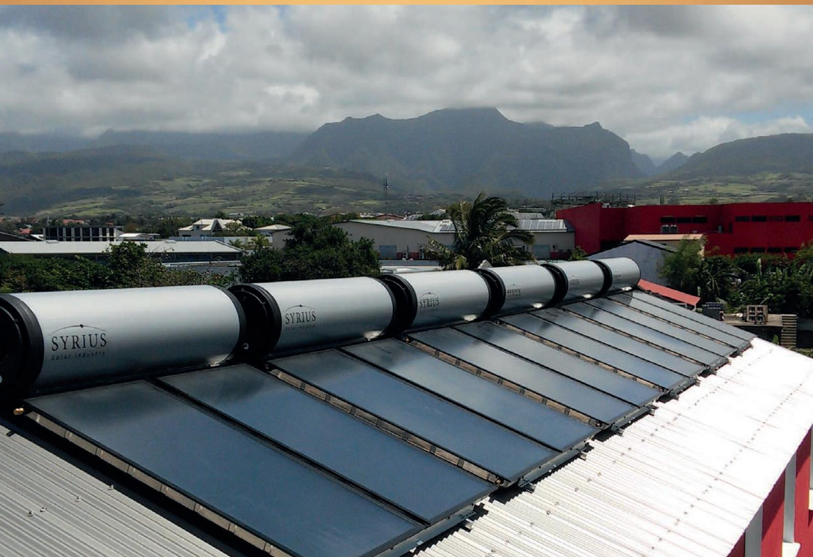
Le chauffe-eau solaire thermosiphon est composé d'un ou plusieurs capteurs solaires et d'un ballon d'eau chaude positionné à l'horizontale, au-dessus des capteurs, sur la toiture.
